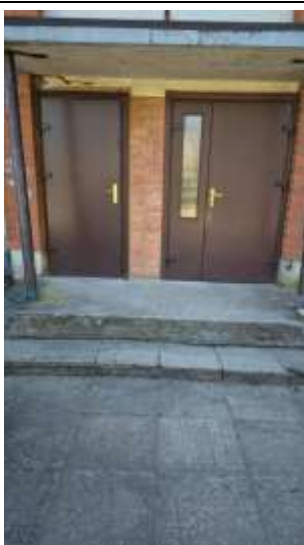
Kāpņu telpas ārdurvis
